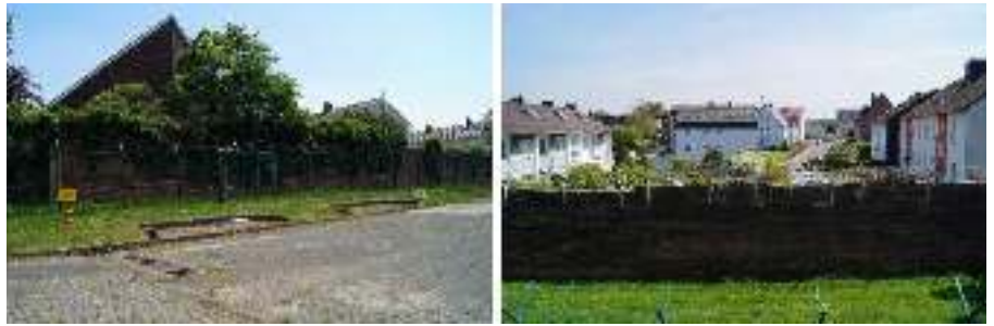
Abb.: Mauer zwischen Kasernengelände und angrenzender Grundstücke Taubenstraße (Quelle: Drees & Sommer SE 2021: 75)
