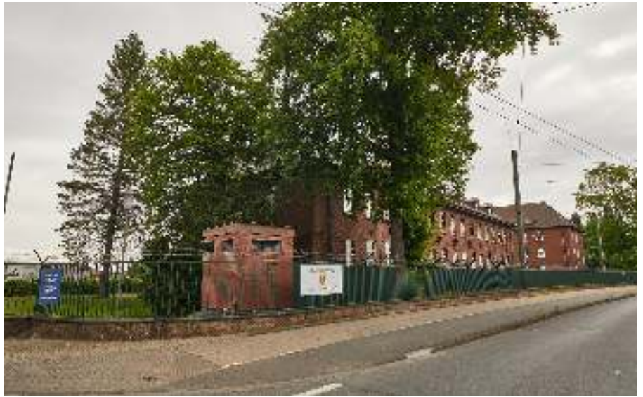
Abb.: Blick von Oldentruper Straße auf Bestandsgebäude Nr. 1 (Quelle: Stadt Bielefeld 2020)
