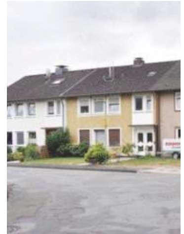
Ein Großteil des Bestands weist starke bauliche Defizite auf
